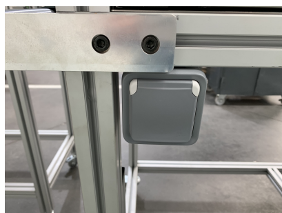
(a) Tomada elétrica.
