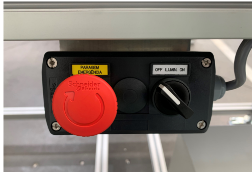
Figura 5.7: Botão de emergência e comutador de iluminação.
