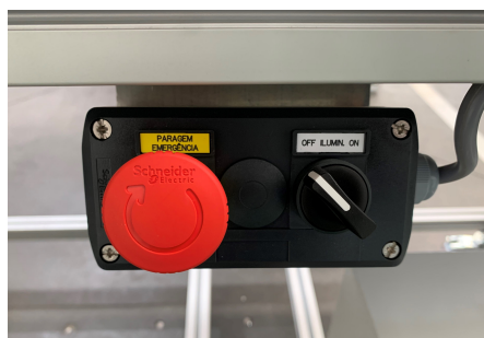
(b) Caixa de botões (Emergência e comutador).
