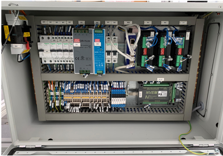
Figura 5.5: Quadro elétrico (porta aberta).
